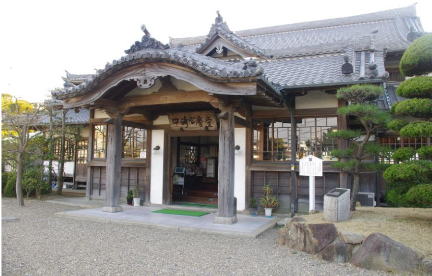
中崎公会堂 全景
